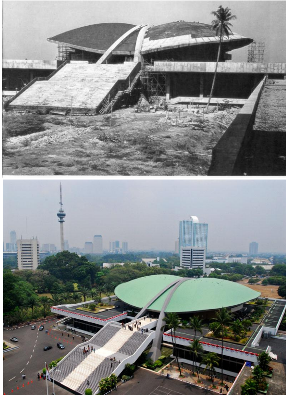
Gambar 33. Pembangunan Gedung MPR/ DPR RI (Conefo) (Atas) dan Desain Gedung MPR/ DPR RI Setelah Rampung (Bawah) (Sumber: Syatria, 1995: 37)
