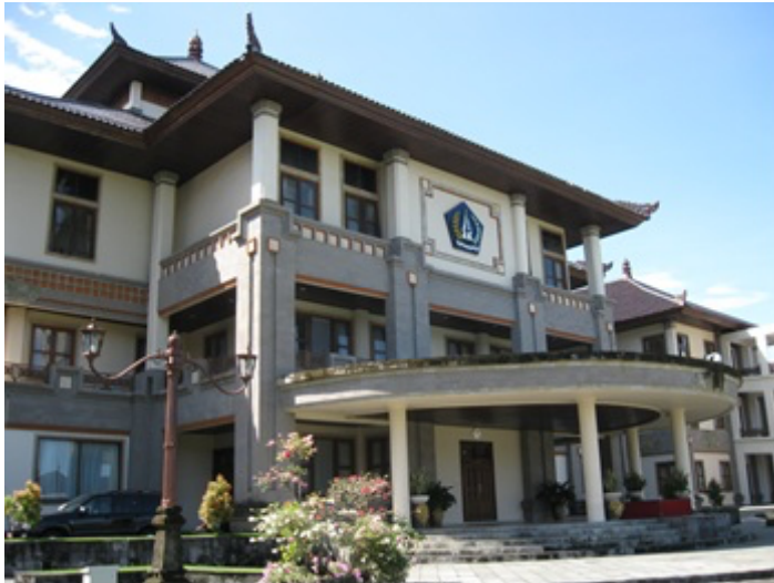
Gambar 31. Material Padas Bata pada Gedung Puspem Badung (Sumber: Dok. Raharja)
