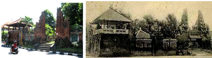
Gambar 30. Kode Desain Tembok Bangunan Gaya Badung Material bata merah kasar di Puri Kesiman (kiri) dan Puri Denpasar (kanan) (Sumber: Dok. Raharja dan Goegle.co.id)
