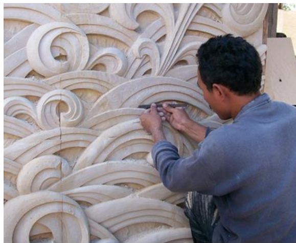
Gambar 5. Proses ngetekung (detail pola setengah jadi)
