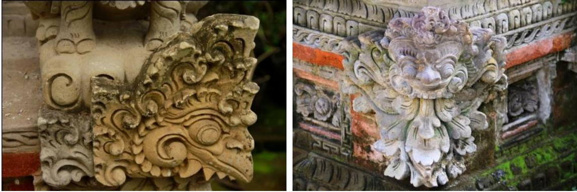
Gambar 5. Contoh Karang Manuk dan Karang Tapel dalam pahatan batu padas di bagian sudut palinggih
