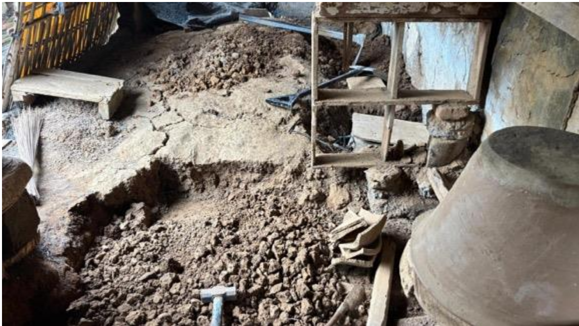
Foto 7.27 Proses Pengayakan Tanah
